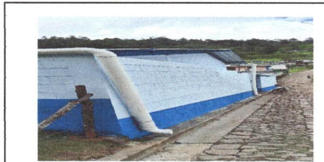
Foto 4. pinturas en muros exteriores.
