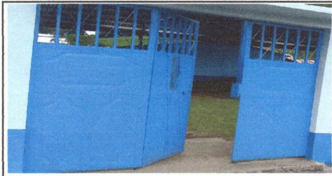
Foto 1. pinturas en muros exteriores.
