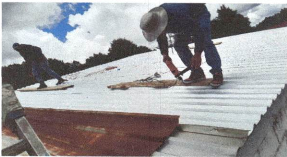
Foto 5. Instalación de lamina troquelada.
