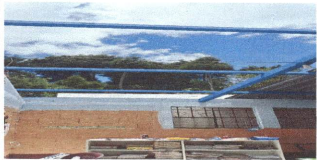
Foto 4. pinturas en muros exteriores.
