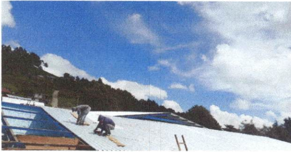
Foto 1. sustitución de lamina por lamina troquelada aluzinc.
