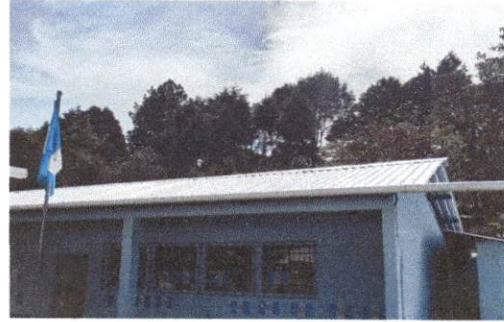
Foto 2 . Canales y bajadas de agua pluvial en modulo de agua.
