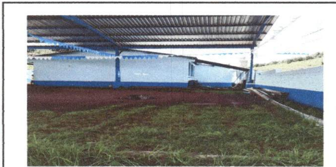
Foto 3. pinturas en muros exteriores.
