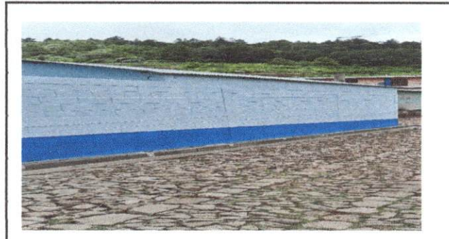
Foto 2. pinturas en muros exteriores.
