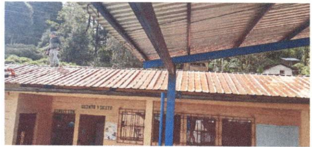
Foto 6. Instalación de bajadas de agua de PVC
